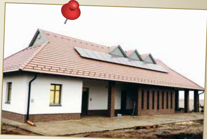
Fontos fejlesztés: nagyon jó ütemben halad a Vásártéri kisközpont épület kivitelezése, ahol mozgáskorlátozott mosdó is létesül
